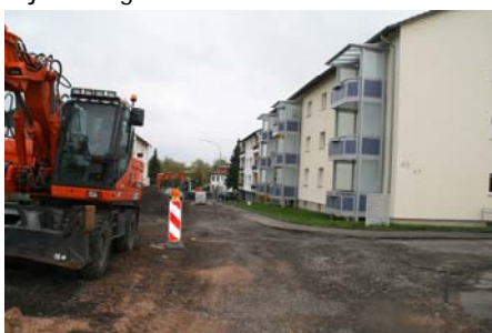
Baumaßnahme in der Kantstraße
