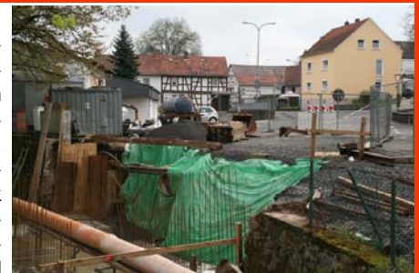
Baumaßnahme in Göbelnrod
