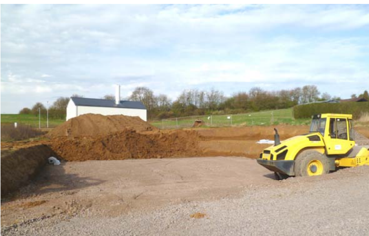
Baustelle Kindertagesstätte Baumgartenfeld
