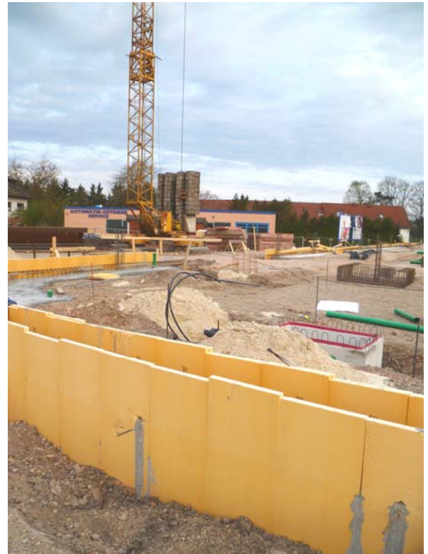
Baustelle am neuen Lidl-Markt
